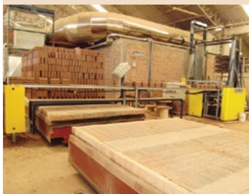
Automatismo de Descarga
