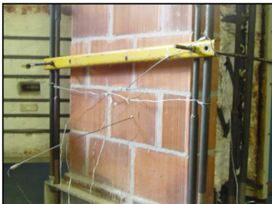
Figura 28 - Painel de alvenaria com termopares conectados
