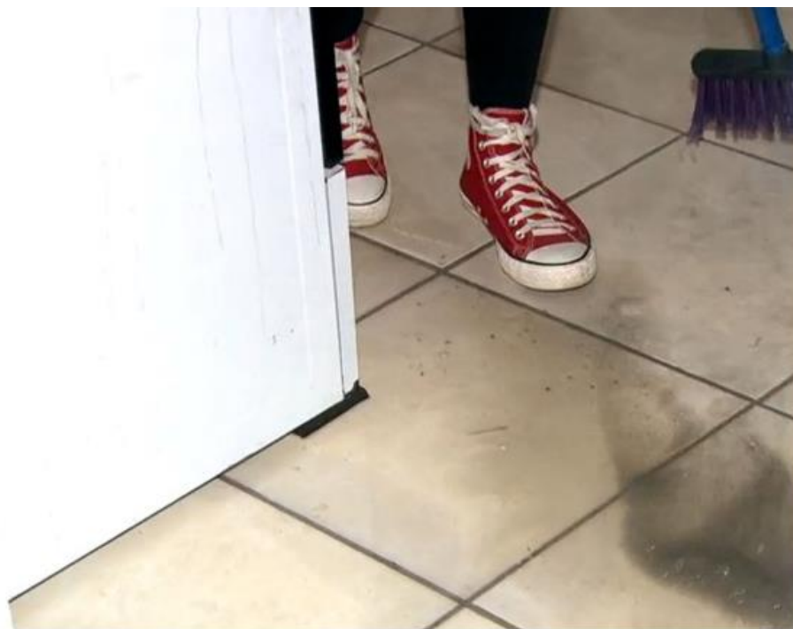
Vazamentos causam prejuízos aos moradores (Foto: Reprodução/TV Globo)
