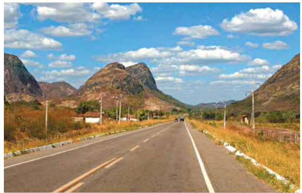
A construção de estradas de asfalto
