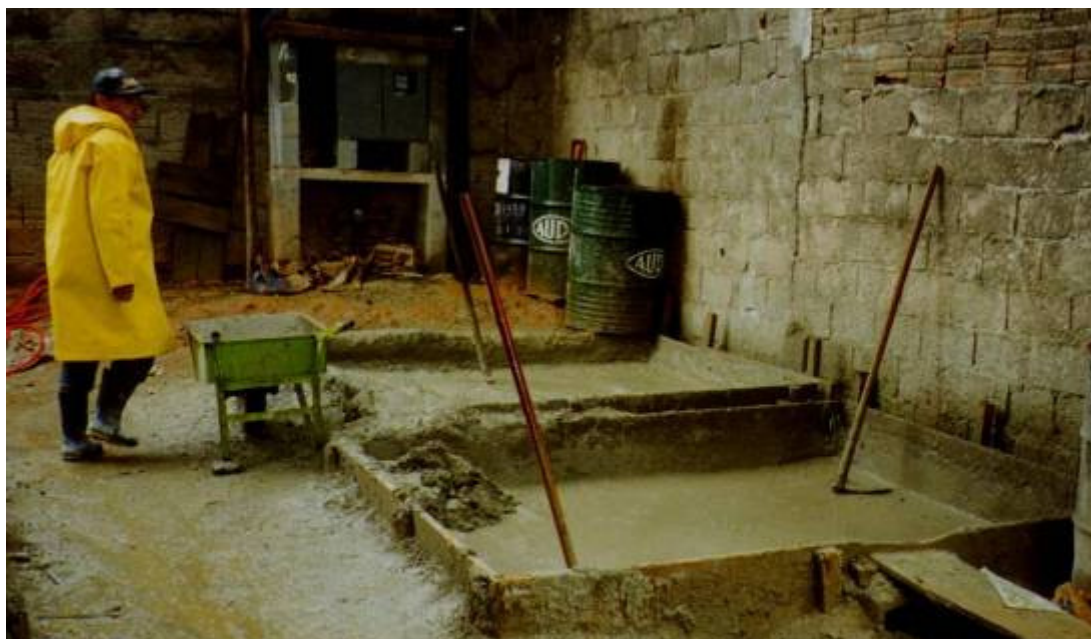
Figura 12 – Local com grandes dimensões para depósito de argamassa de assentamento.
