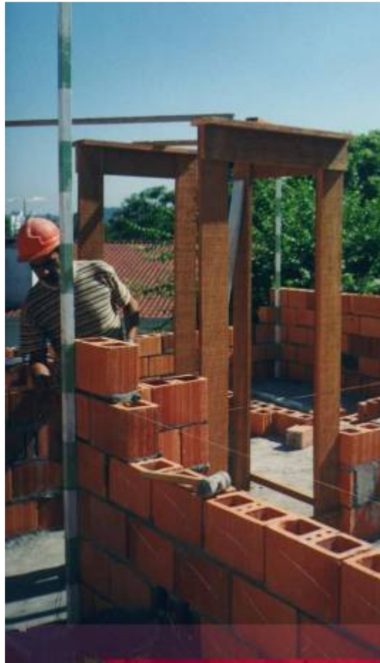
Figura 15 – Escantilhão usado em obras de alvenaria estrutural.
