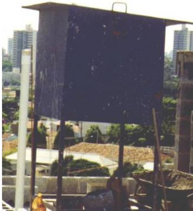
Figura 6 – Cabina móvel para armazenar plantas e outros objetos no andar de execução da alvenaria.
