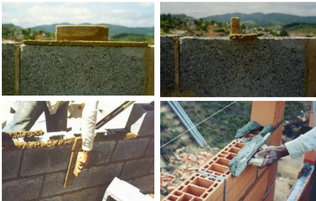
Figura 18 – Palheta utilizada para o assentamento de blocos.
