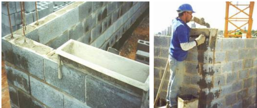
Figura 20 – Fôrma utilizada para facilitar a colocação do graute no interior dos vazados dos blocos.
