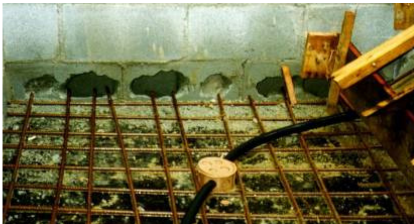
Figura 28 – Quebras em blocos para fixação do patamar da escada às paredes.
