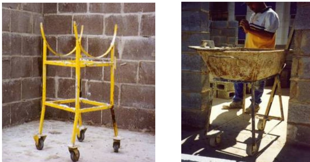
Figura 13 – Estruturas de colocação da caixa de argamassa para execução da alvenaria.
