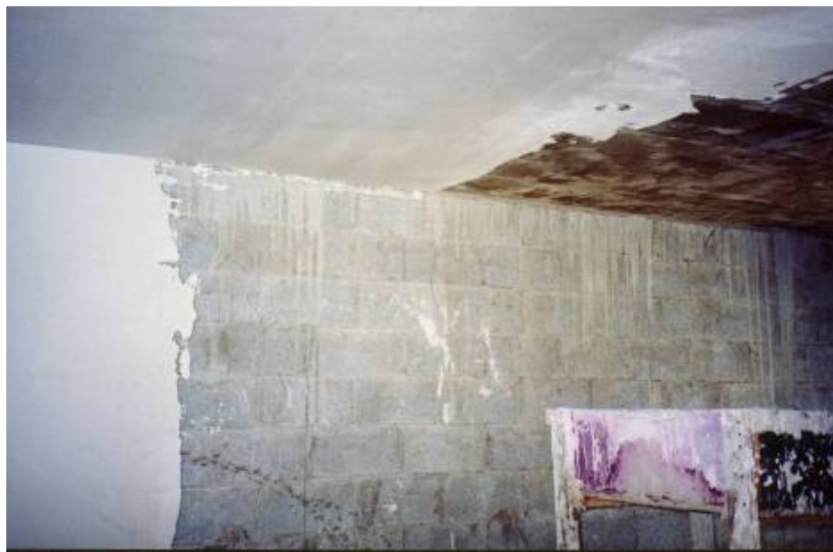
Figura 32 – Revestimento interno em gesso, aplicado diretamente sobre o bloco.
