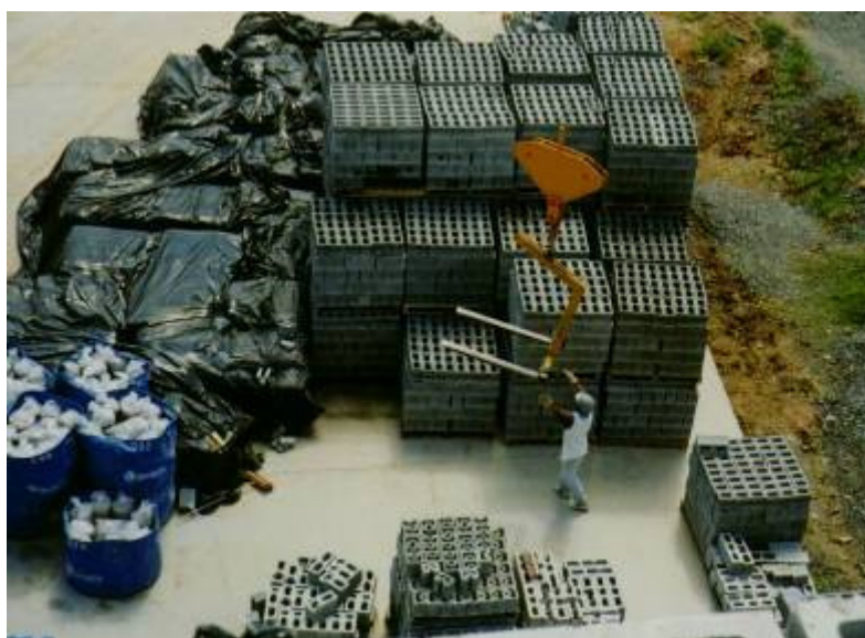
Figura 5 – Blocos armazenados na obra sobre estrados de madeira e protegidos, da ação direta de intempéries, com lona plástica.
