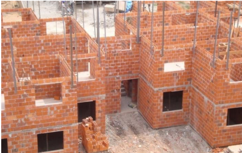
Figura 3.1: Sistema construtivo em alvenaria estrutural.
