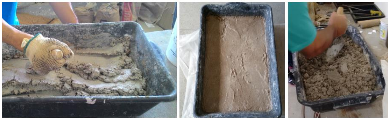
Figura 4.8: Preparo da argamassa de assentamento dos prismas
